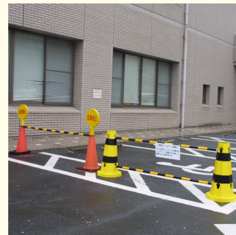
【工事中仮設資材】
